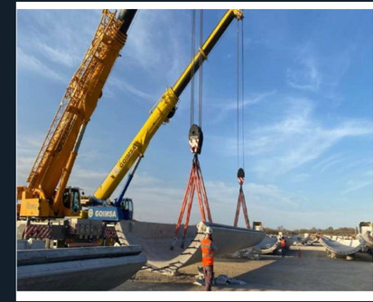
Descarga, izado y preparación para montaje · Santa Cruz
