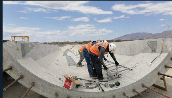
Instalación mecánica y preparación de internos · San Carlos
